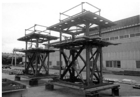
図-3 アンカーボルト固定冶具仮組み立て状況
