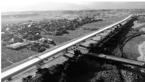
図-1 南大社3高架橋
