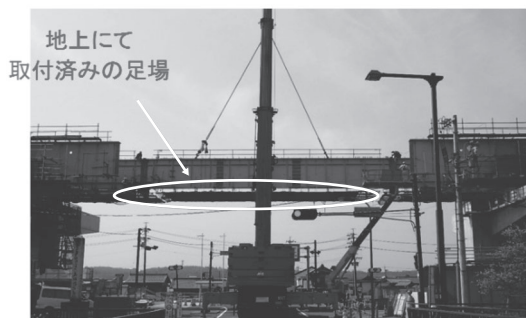
図-3 足場先行設置後の桁架設
