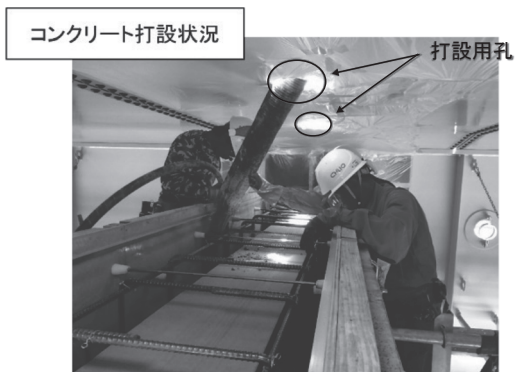
図-4 巻立てコンクリート打設用孔
