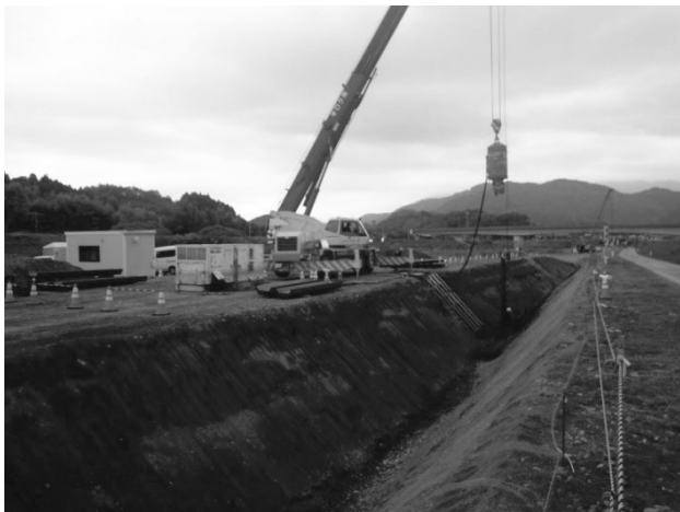
図-3 止水矢板打込み
