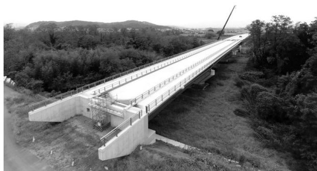
図-5 完成した新錦川橋
