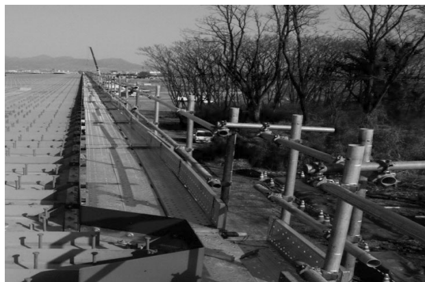
図-4 合成床版張出し足場設置状況
