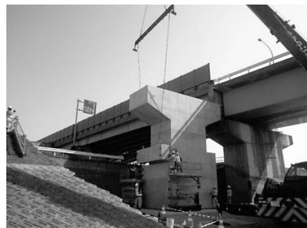
図-4 鞘管ブロック 据付状況
