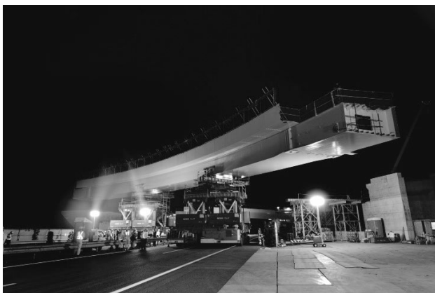
図-1 キャリヤ架設状況
