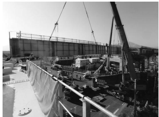
図-4 交差点桁架設状況
