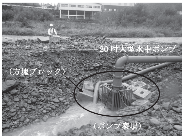
図-4 ポンプ釜場設置状況
