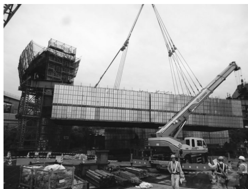
図-5 試験吊り状況
