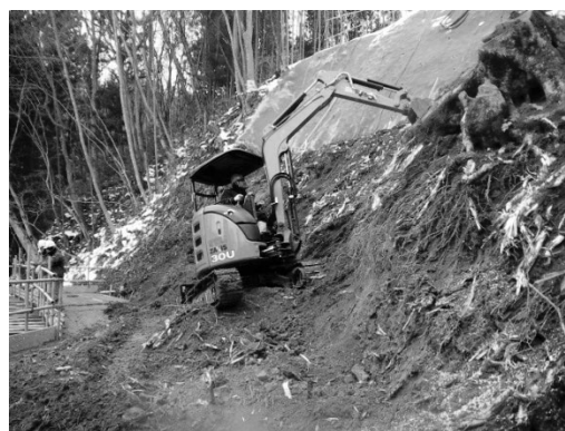
図-4 重機足場による切土作業状況
