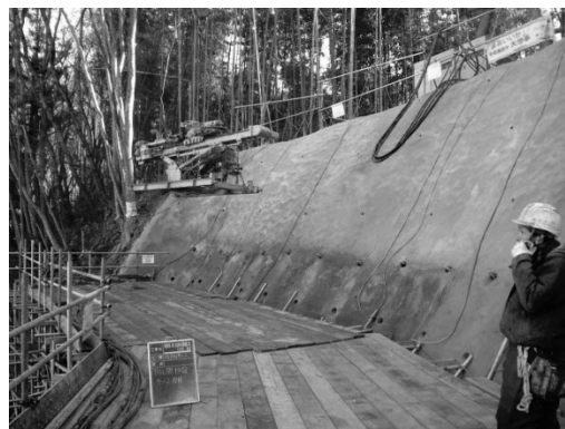
図-5 削孔機運搬状況
