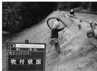
図-7 吹付法枠施工
