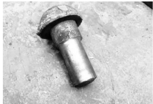
図-4 撤去後のリベット
