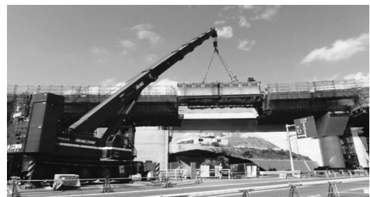
図-6 J24-J25落とし込み架設
