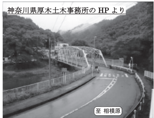
図-1 旧橋供用時
