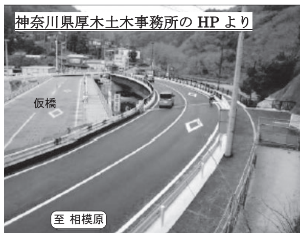
図-3 新橋供用状況
