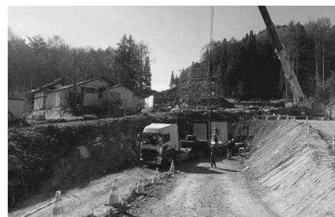
図-5 製品搬入状況
