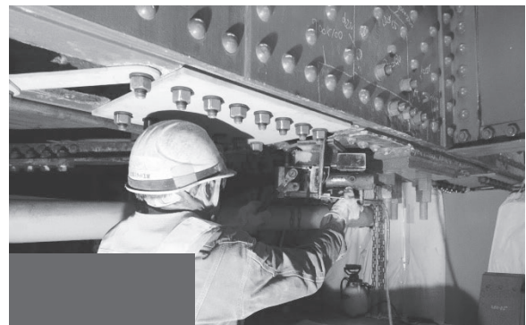
図-9 下弦材当て板部リベット撤去（アトラーで削孔）
