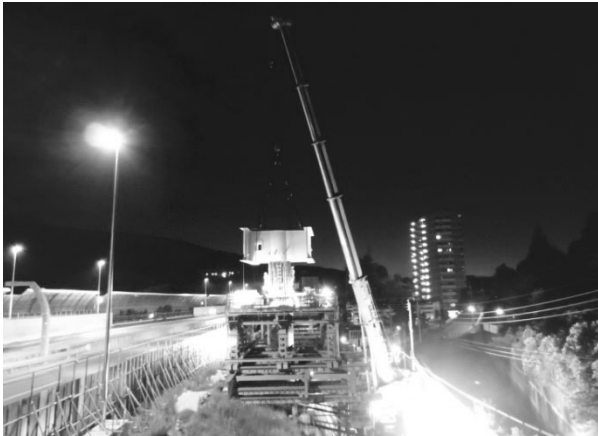
図-5 剛結部鋼製橋脚架設状況
