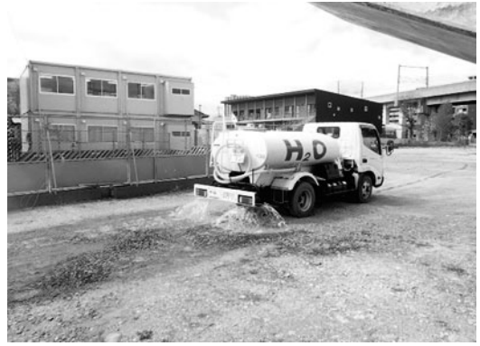
図-2 散水車による散水状況
