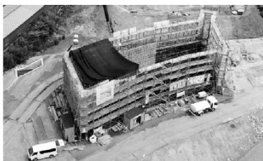
図-5 遮光養生状況
