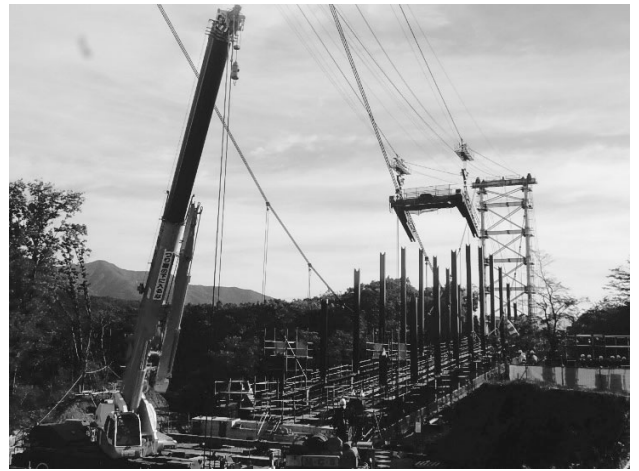
図-9 アーチリブ架設状況
