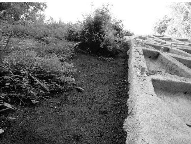
図-3 地山境目基盤材吹付け
