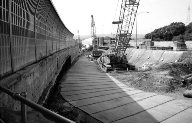
図-9 軌条部ヤード状況
