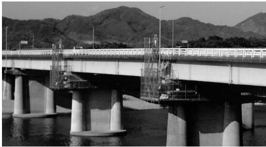
図-9 足場支保工の組換え後
