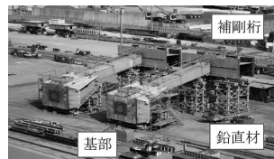
図-4 分割仮組立 (立体) 図-5 分割体組立 (平面)
