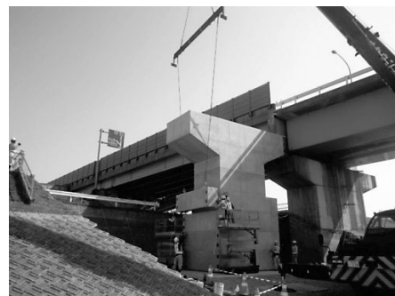
図-4 鞘管ブロック 据付状況
