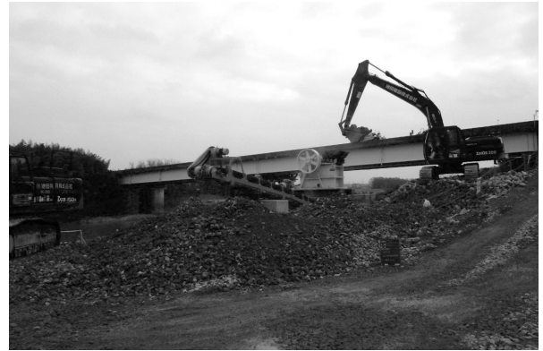
図-4 破碎機による硬岩破碎状況
