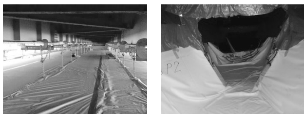
図-4 シート養生状況（下段・中段）
