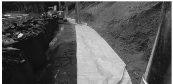
図-5 シート敷きによる作業環境の改善
