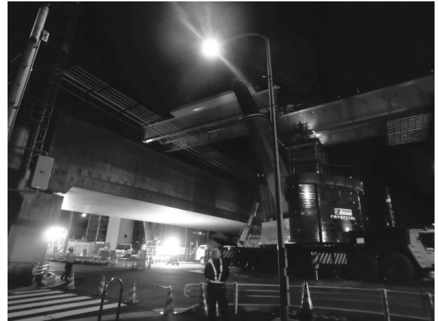
図-4 近鉄上の架設状況
