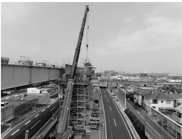
図-3 内回り側径間架設状況
