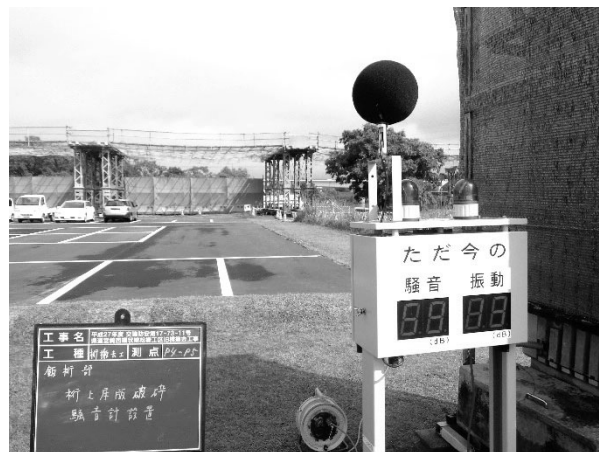
図-8 桁上コンクリート破砕時
