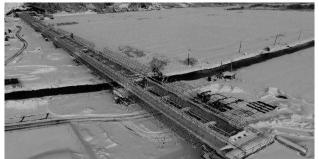
図-5 足場(骨組)設置状況
