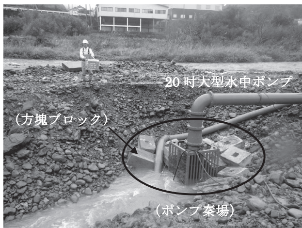
図-4 ポンプ釜場設置状況
