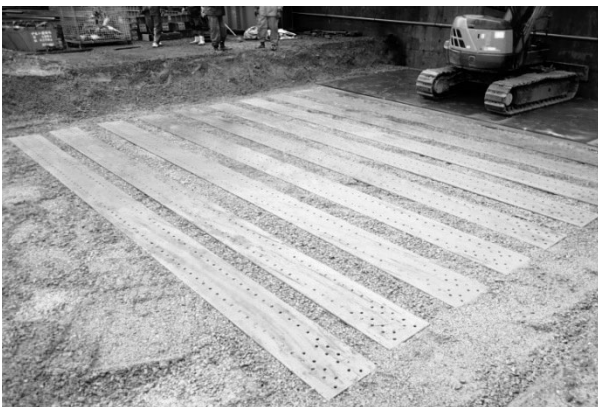
図-11 強化路盤状況
