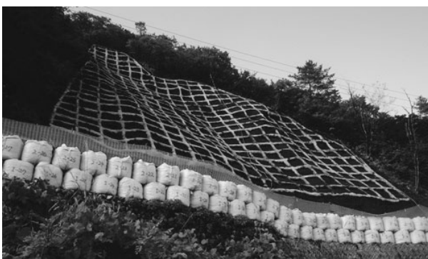
図-2 施工完了直後
