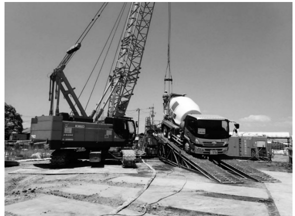
図-5 施工状況（敷鉄板使用）
