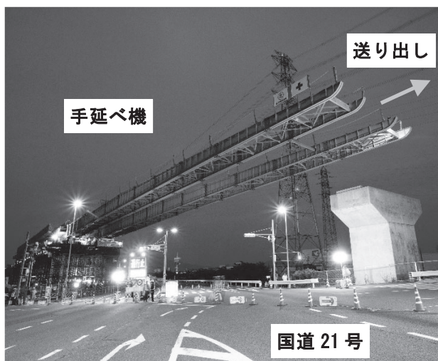
図-1 国道上の送り出し架設状況
