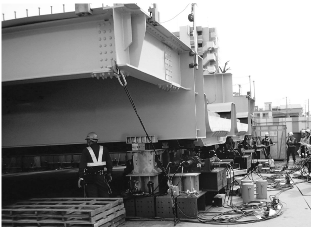
図-7 XY調整装置による位置調整確認
