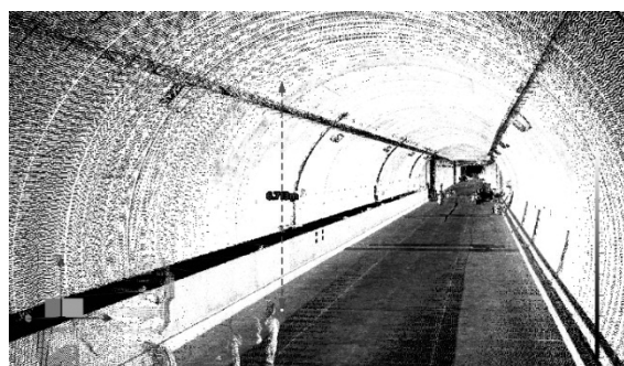
図-6 トンネル内部の高さ計測の一例
