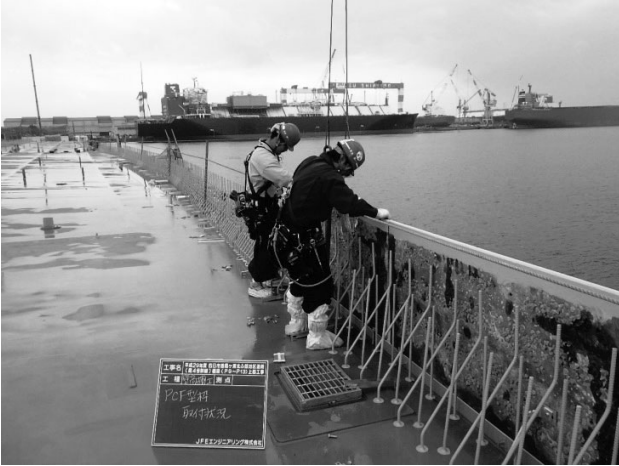
図-7 PCF型枠工法の壁高欄外型枠への適用（地組立時先行取付）
