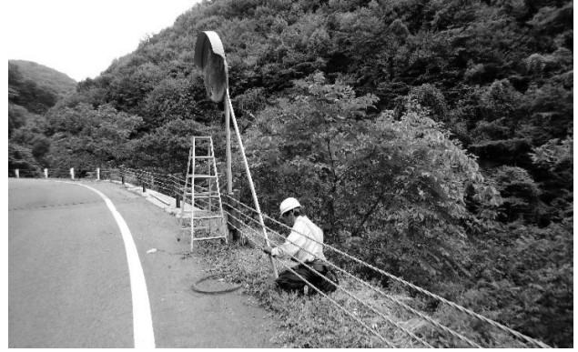
図-5 カーブミラー設置
