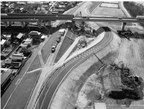
図-1 現場全景写真
