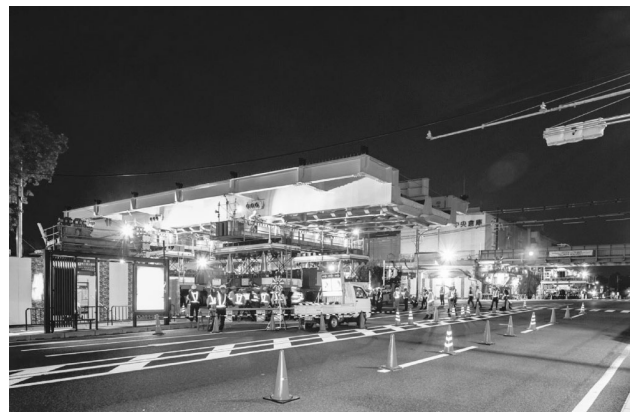
図-6 新設桁勾配調整試験
