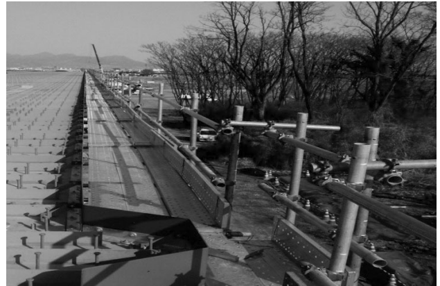
図-4 合成床版張出し足場設置状況
