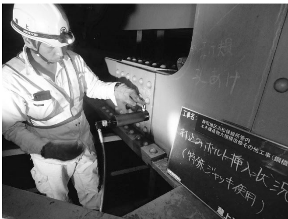
図-9 高力ボルト引込み状況
