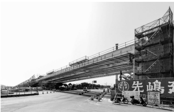
図-10 架設完了状況
