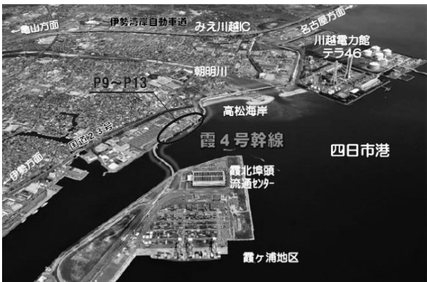
図-1 霞4号幹線全景（国土交通省中部地方整備局 HP より）
