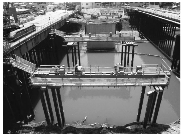
図-4 ベント組立完了
