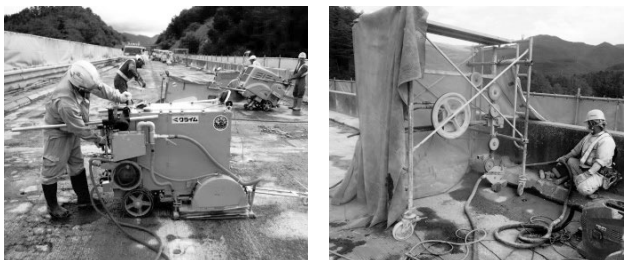
図-3 地覆部・壁高欄部コンクリート切断状況
