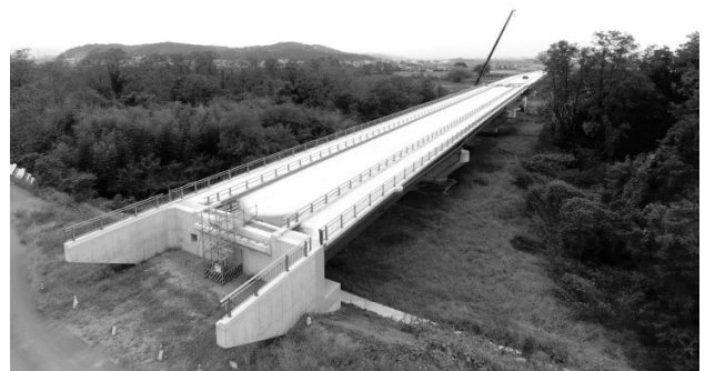
図-5 完成した新錦川橋
