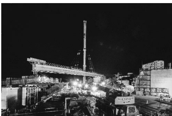
図-9 大型クレーン桁旋回状況
