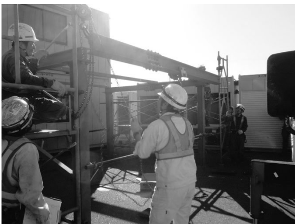
図-6 部材取込設備の仮組立状況
