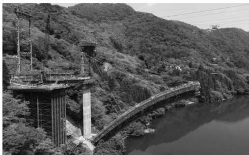
図-4 アーチ架設状況
