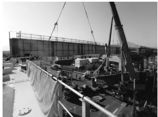
図-4 交差点桁架設状況
