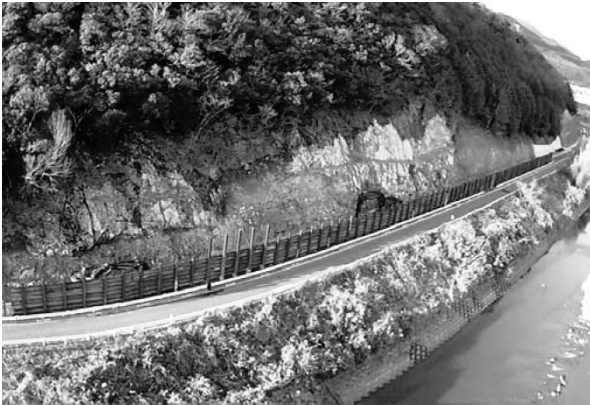
図-2 仮設防護柵設置状況
