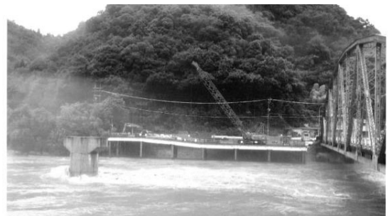
図-4 平成30. 7. 7 西日本豪雨時の状況
