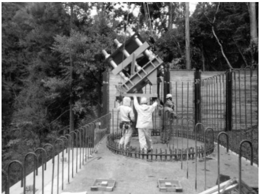
図-5 支承アンカーフレーム据付状況
