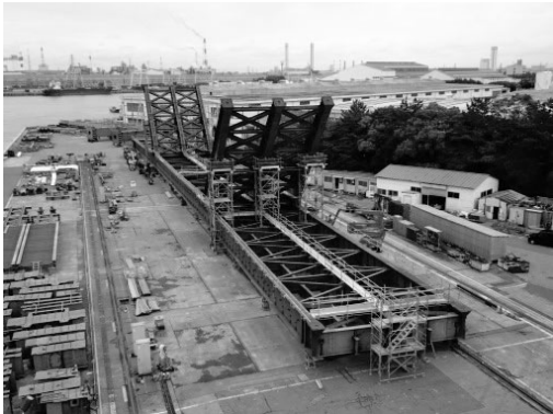
図-4 仮組立状況
