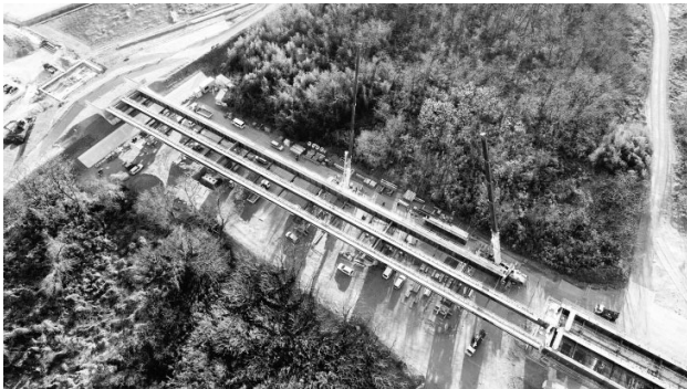
図-3 桁架設状況 (河川敷内でのトラッククレーン+ベント工法)
