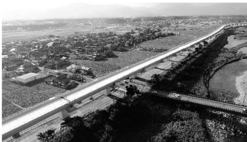
図-1 南大社3高架橋
