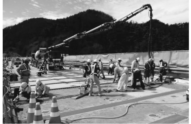
図-7 間詰め部コンクリート打設状況
