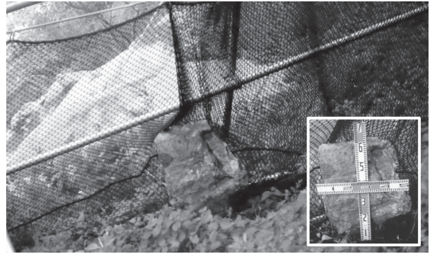
図-9 落石捕捉状況
