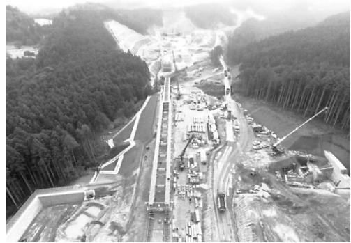
図-2 下り線 送り出し架設状況
