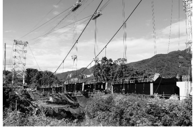
図-8 補剛桁架設状況
