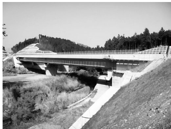
図-11 完成した金溪川橋
