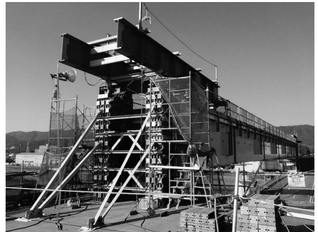
図-4 降下設備固定状況
