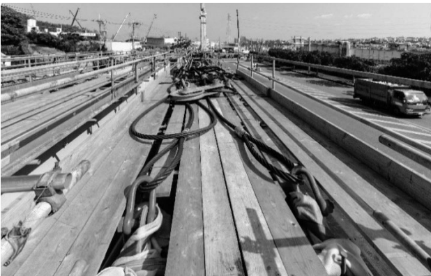
図-5 大ブロック桁上の玉掛け設備の事前設置状況
