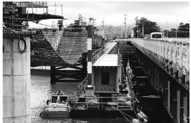
図-2 ユニフロート上での地組立
