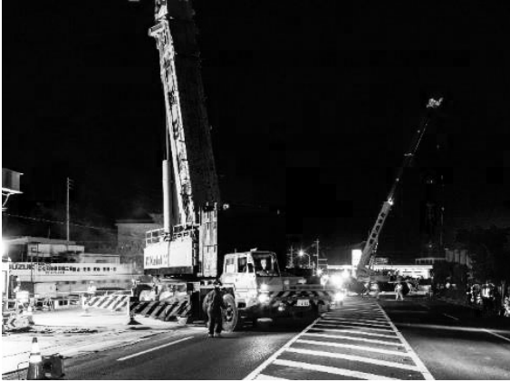
図-4 大型クレーンの自走状況
