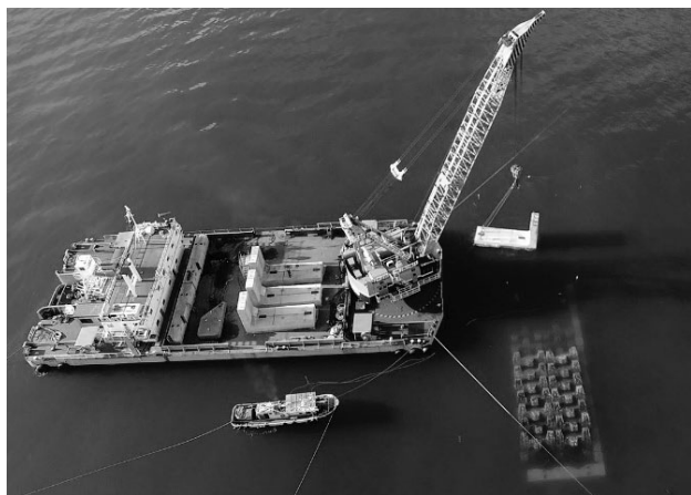
図-4 連結したL型ブロック据付状況
