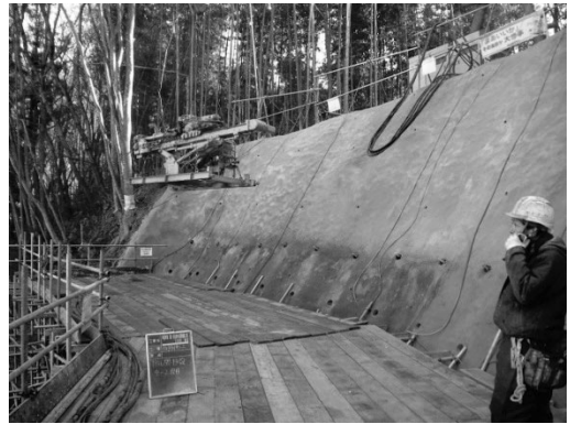
図-5 削孔機運搬状況
