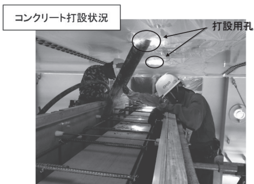
図-4 巻立てコンクリート打設用孔
