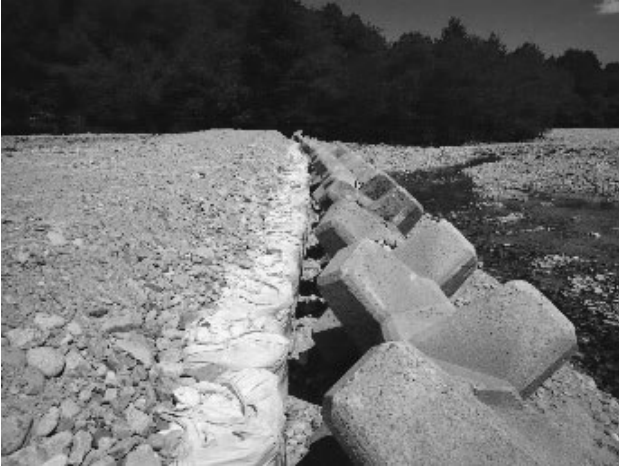
図-9 大型土のう異形ブロック設置状況写真
