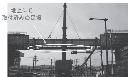
図-3 足場先行設置後の桁架設
