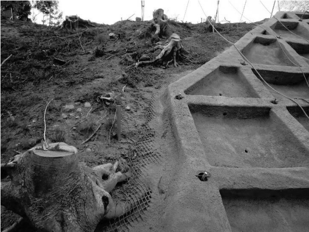
図-2 地山と法枠境目状況
