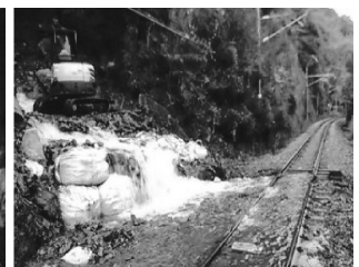
図-2 法面湧水状況
