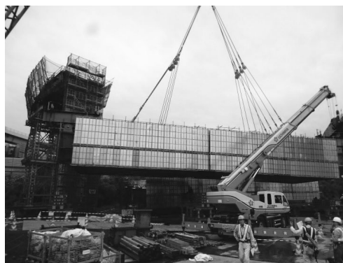
図-5 試験吊り状況
