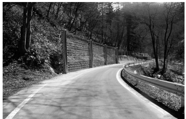
図-6 落石防護柵工竣工
