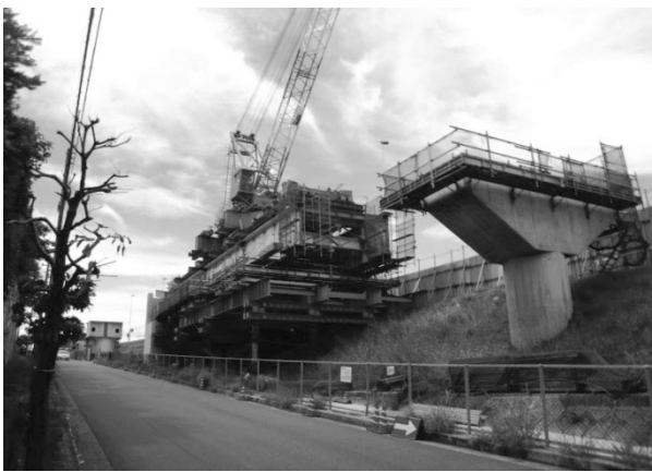
図-6 トラベラークレーンによる鋼桁架設状況
