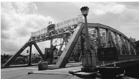
図-1 犀川大橋全景（片町側から野町側を望む）
