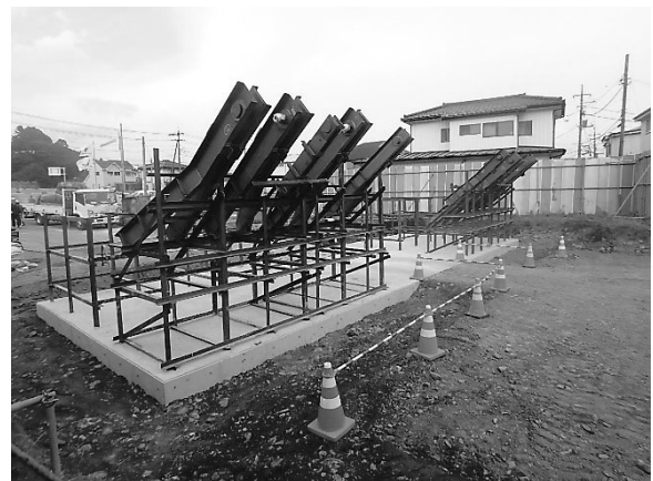
図-8 コンクリートブロック施工状況
