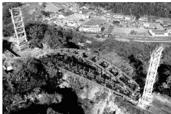
図-1 ケーブルクレーン設備（全景）
