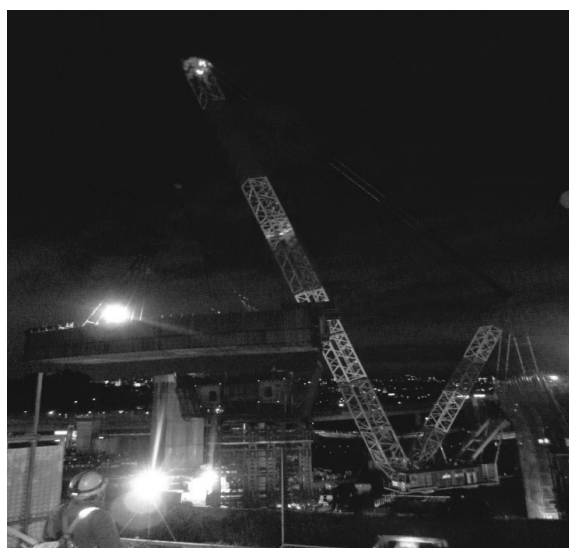
図-3 鋼桁大ブロック夜間一括架設状況
