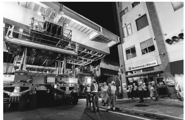
図-9 ビルの直前を走行する新設桁
