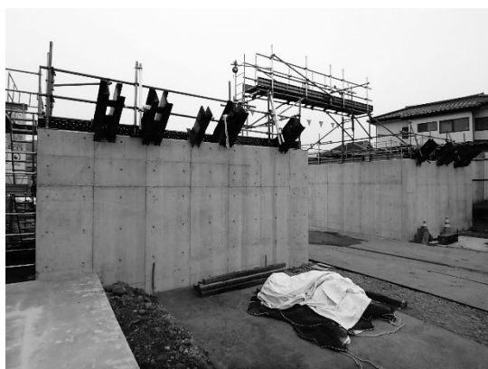
図-10 コンクリートブロック施工完了
