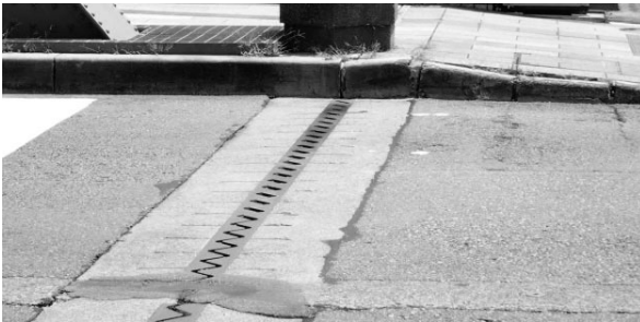
図-2 伸縮装置損傷状況（車道部の段差）
