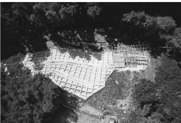
図-1 法枠工施工状況
