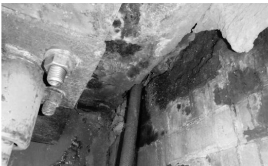
図-4 橋台損傷状況 （伸縮装置下部）
