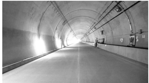
図-1 トンネル内部
