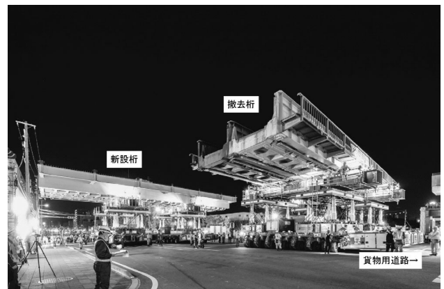
図-8 貨物用道路に移動する既設桁
