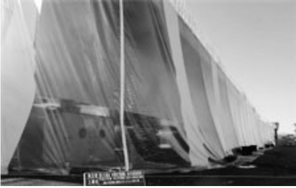
図-4 地組立継手塗装作業時の養生設備
