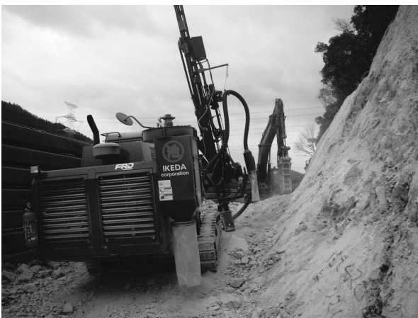
図-3 併用掘削状況
