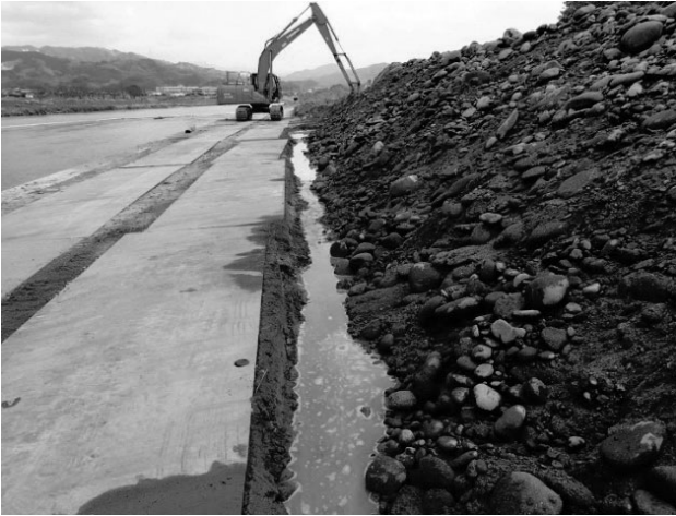
図-3 仮置き・素堀側溝（脱水）
