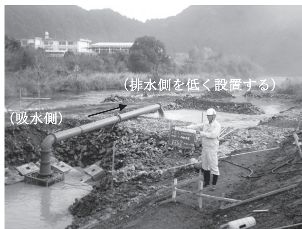
図-5 水中ポンプ配管状況
