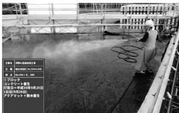
図-6 湿潤・保温養生マット
