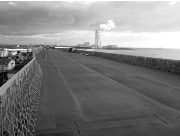
図-8 大ブロック架設後橋面状況
