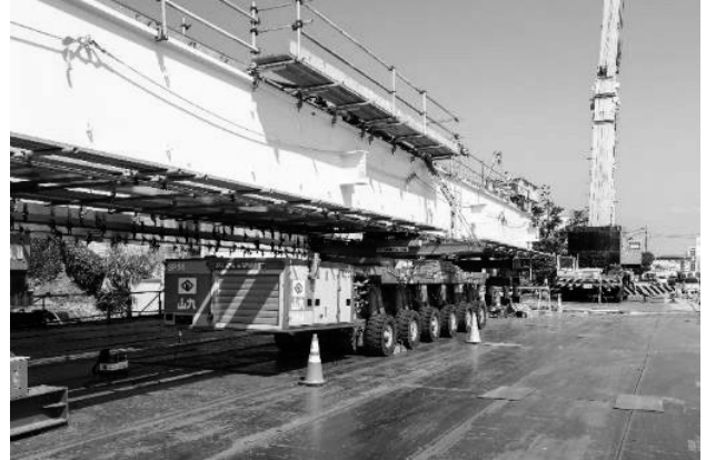
図-6 多軸台車への支持荷重の受け替え作業状況
