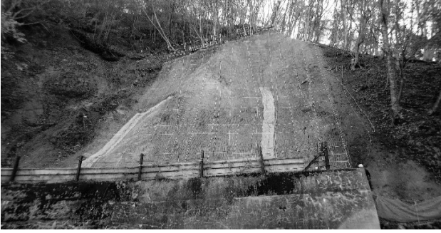
図-2 吸出防止材敷設
