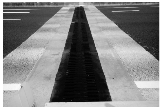
図-8 伸縮装置の設置・施工の完了状況
