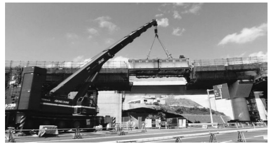
図-6 J24-J25落とし込み架設
