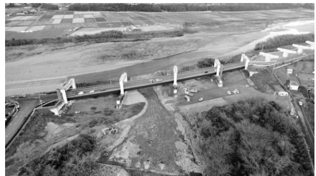
図-3 作業ヤード整備
