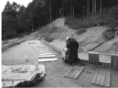
図-3 外部保護材組立
