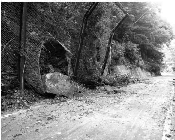
図-1 巨石崩落状況
