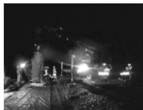
図-8 軌陸クレーン作業
