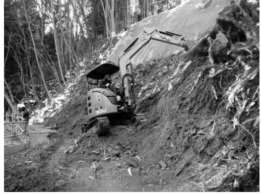
図-4 重機足場による切土作業状況
