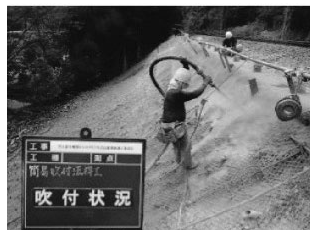
図-7 吹付法枠施工
