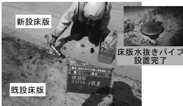
図-9 床版水抜きパイプの設置状況
