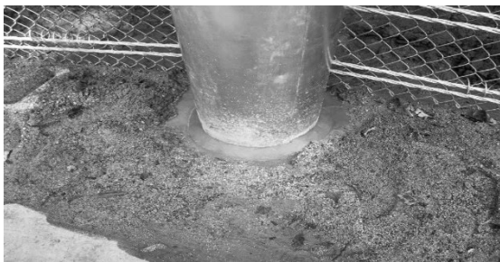
図-4 杭基礎周りモルタル保護
