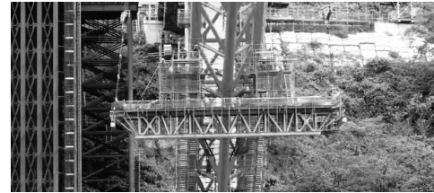
図-5 搭乗設備による足場解体状況
