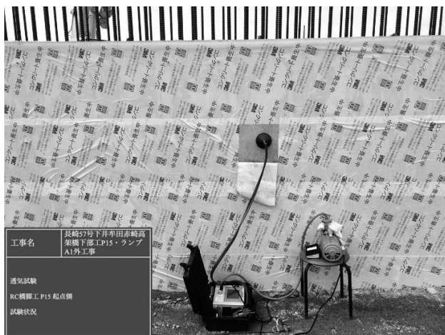
図-5 透気試験（本施工時）
