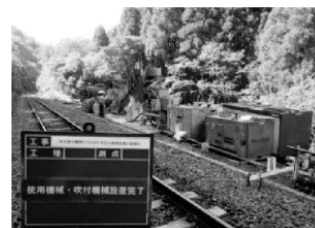
図-9 吹付プラント
