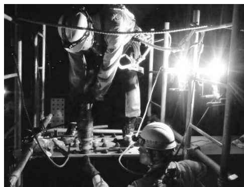
図-4 ピン圧入機械使用状況
