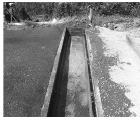
図-4 土砂撤去完了
