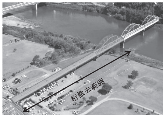
図-1 旧相生橋 着工前
