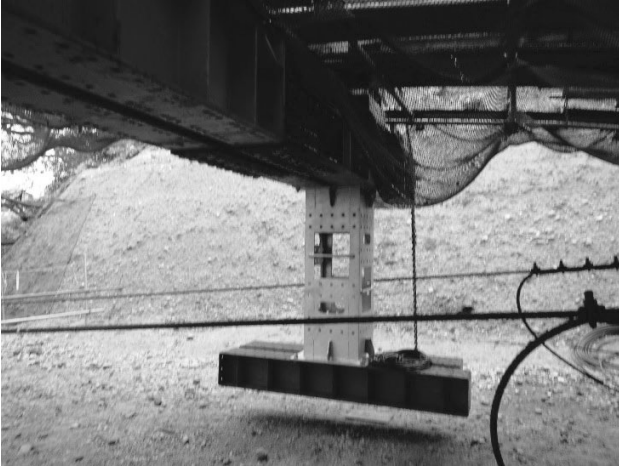
図-7 受梁直下バント設備
