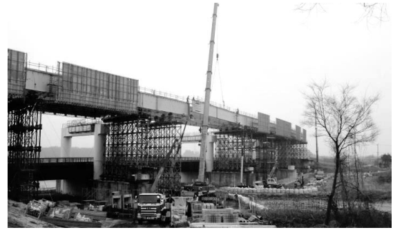
図-6 架設・足場設置状況
