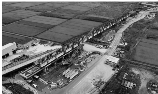
図-2 架設状況全景
