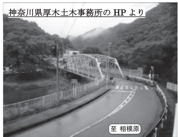
図-1 旧橋供用時
