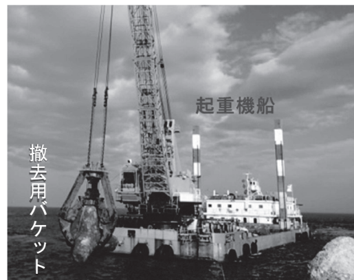
図-2 ブロック撤去状況
