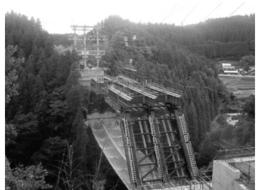
図-9 閉合ブロック架設状況
