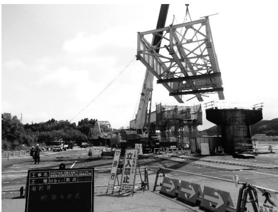
図-7 鈹桁部撤去状況
