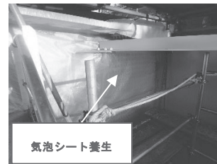
図-12 気泡シート養生
