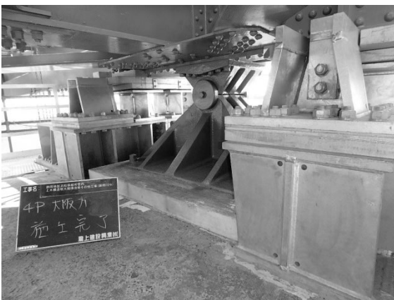
図-1 施工後の支承
