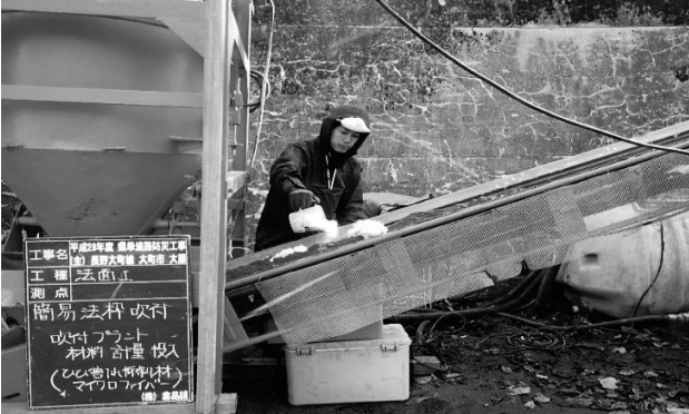
図-3 吹付け混合状況、巻き込みシート設置
