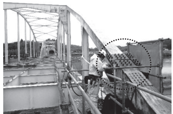
図-6 初期切断状況 (エレクションピースを取り付けて切断)
