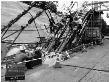
図-8 斜吊り調整状況
