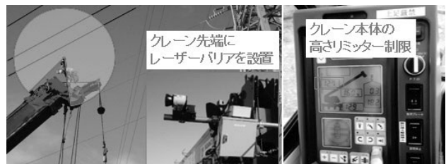
図-7 クレーン作業中の高圧送電線の監視
