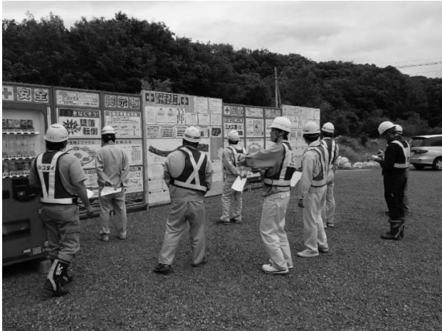
図-2 現場パトロール実施状況写真
