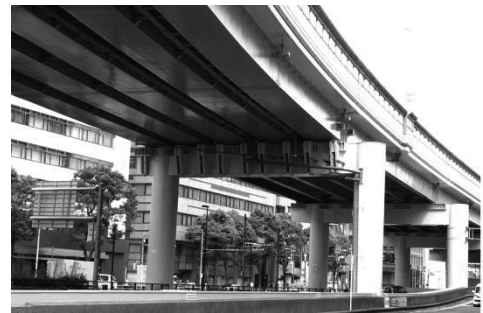
図-1 池115・116橋脚全景（完成後）
