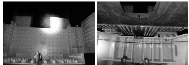
図-6 取替完了状況(左：桁内、右：桁外)
