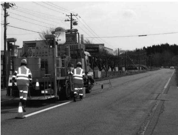
図-1 中央線の復旧状況
