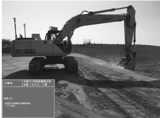
図-8 盛土端部の施工状況
