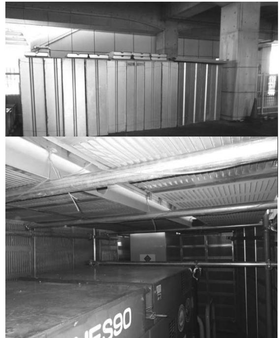
図-7 発電機の吸音板の設置状況
