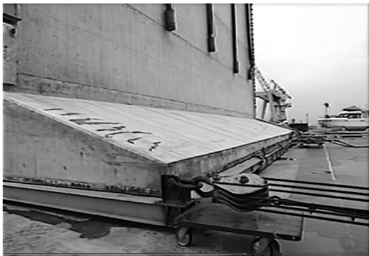
図-9 移動中の3,000トン複合ケーソン
