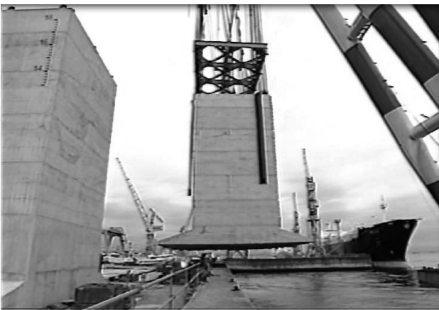
図-1 浜出し中の複合ケーソン
