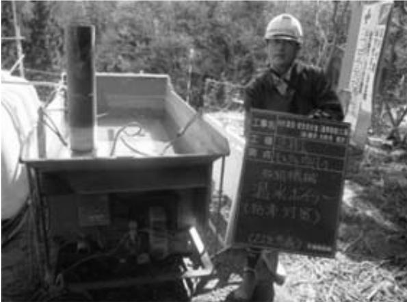
図-7 温水ボイラー設置状況
