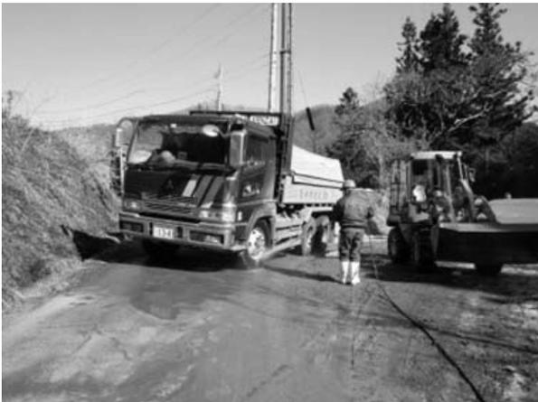
図-8 車両タイヤ洗浄状況
