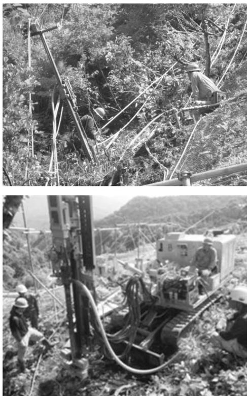
図-7 上：吊り下げ式削孔機（スカイドリル）
