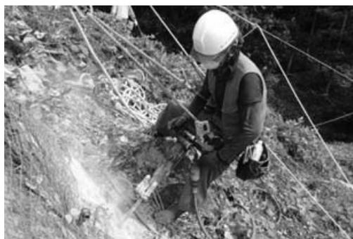
図-3 削岩機による削孔作業状況
