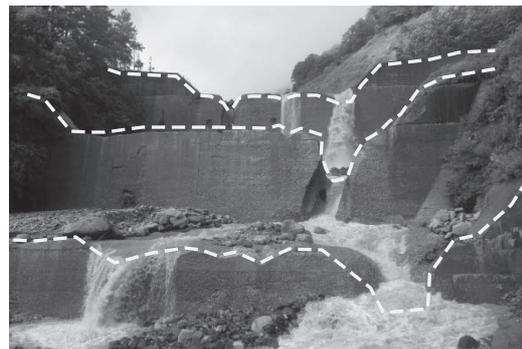
図-1 浦川砂防堰堤 摩耗・損傷状況
