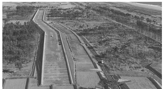
図-1 盛土完成写真
