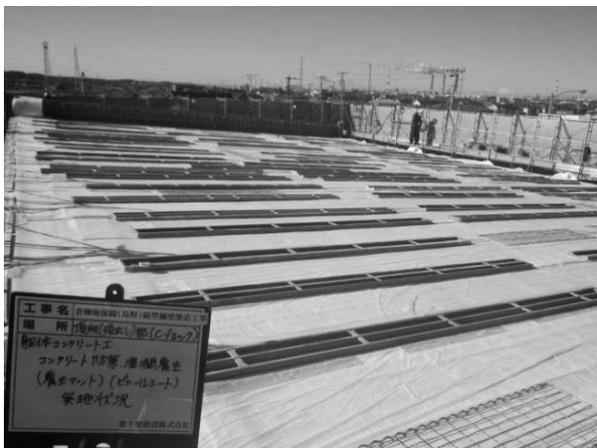
図-5 太陽光熱による密閉養生
