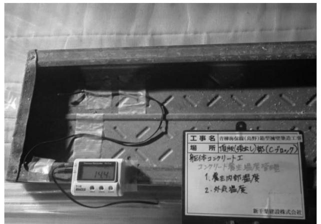
図-6 温度計測管理
