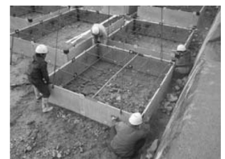
図-12 下段型枠設置状況
