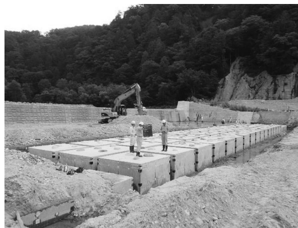
図-15 護床工完了
