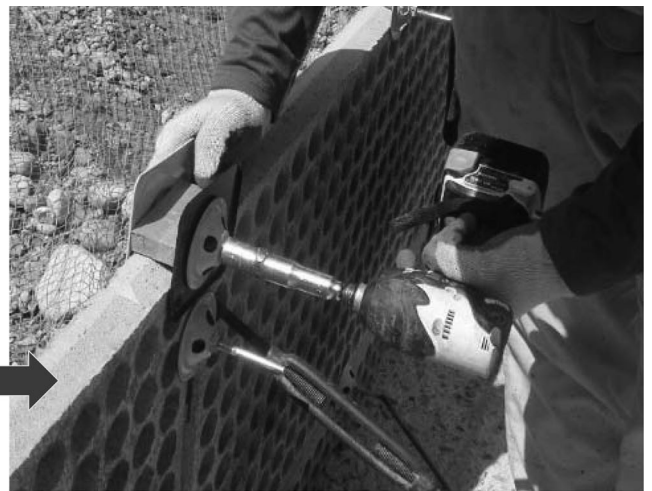
図-9 ボックスレンチ使用状況
