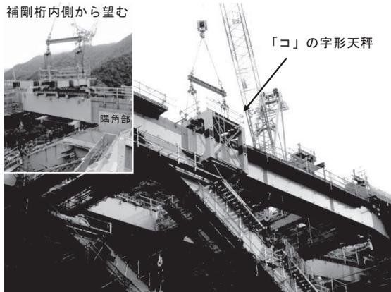
図-11 「コ」の字形天秤による架設状況
