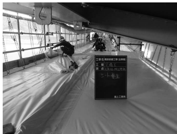
図-13 防滴シート設置状況
