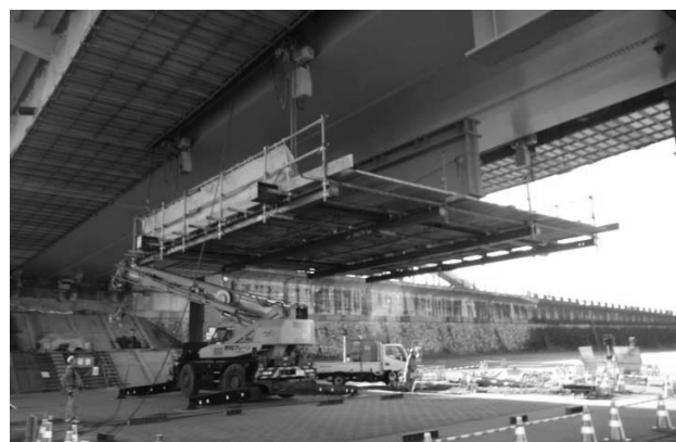
図-9 仮受ブラケット荷上げ状況
