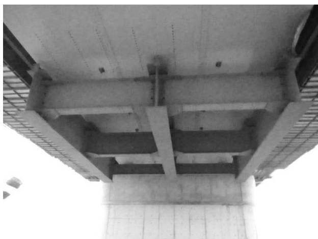
図-6 仮受ブラケット設置状況
