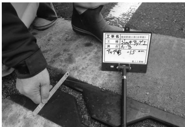
図-11 伸縮装置計測状況
