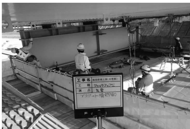
図-10 仮受ブラケット設置状況
