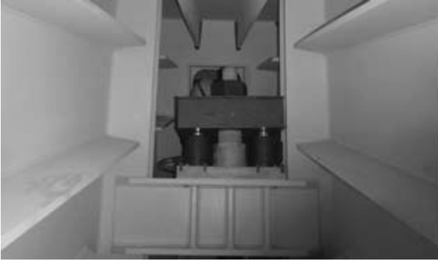
図-2 ケーブル張力調整
