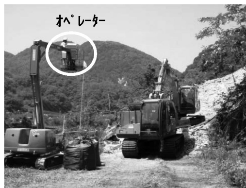
図-7 崩土積込状況
