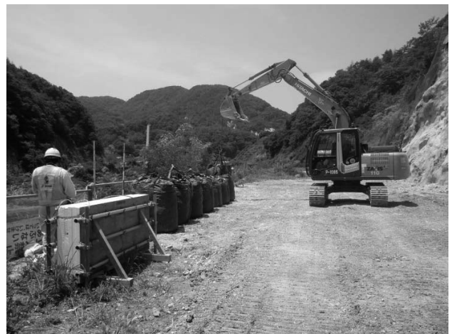
図-11 大型どこのう設置状況
