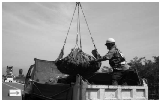
図-3 ワイヤーモックでの土砂積込
