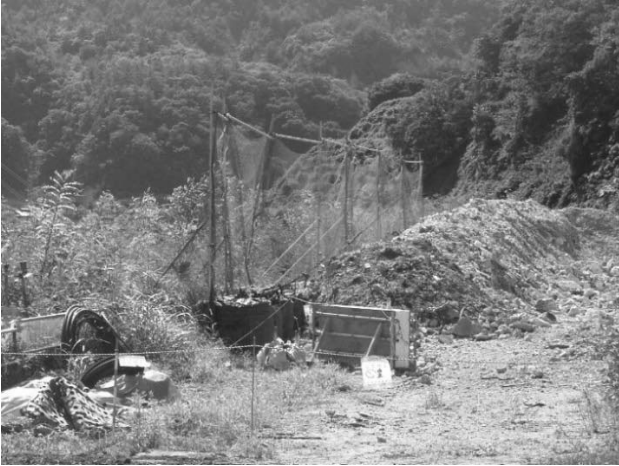
図-12 人力整形土石の集積状況
