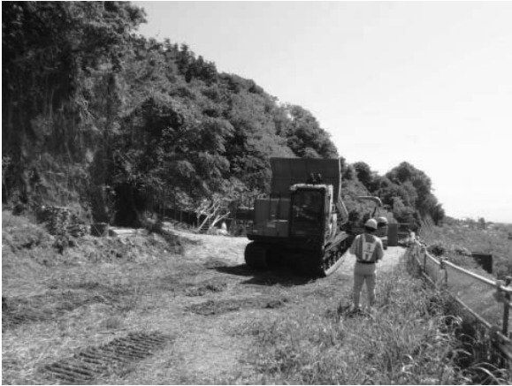
図-8 崩土小運搬状況
