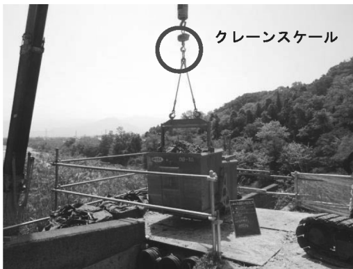
図-13 重量検収状況
