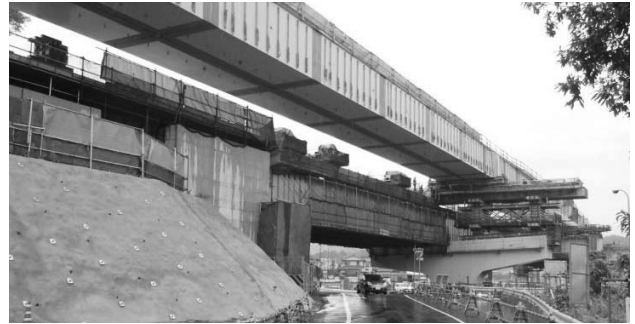
図-9 マジックスライド装置による横取り
