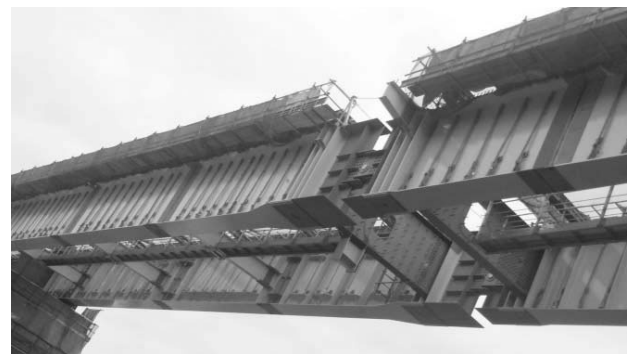
図-5 重連式送り出し架設①
