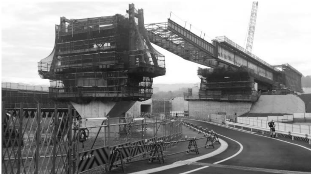
図-7 鉛直上方に上げ越した手延べ機①
