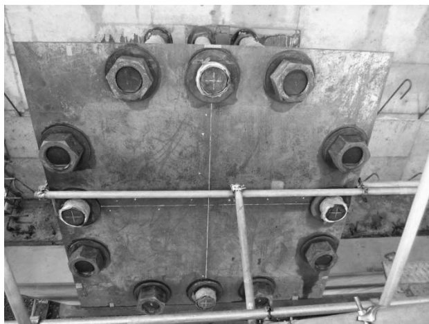
図-4 アンカーボルト間隔保持材
