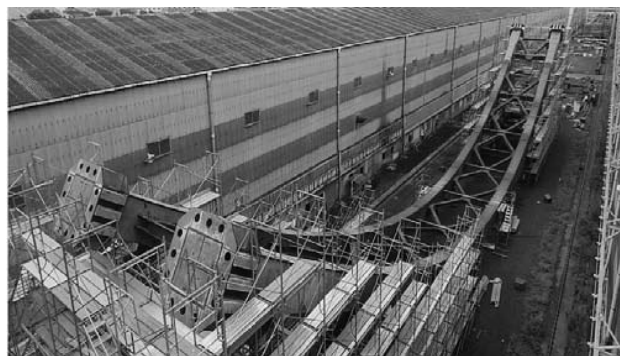
図-3 アーチ部材の倒立一体仮組立
