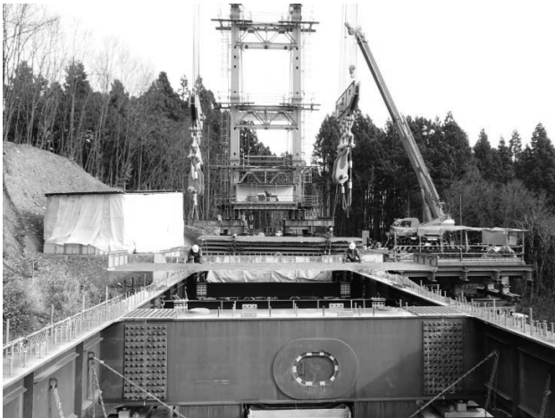
図-10 合成床版鋼製パネル架設状況
