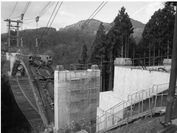
図-6 アーチ部材の斜吊り設備
