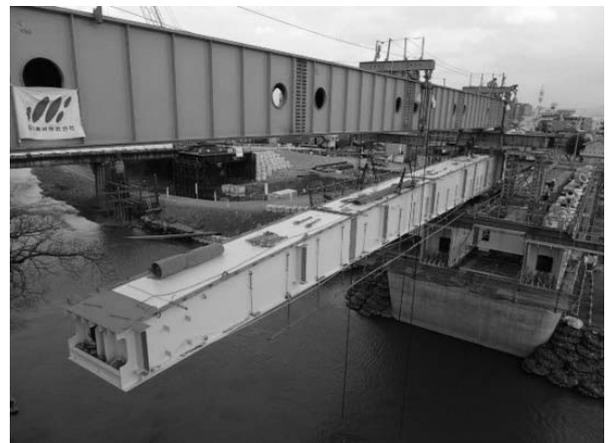
図-5 桁送り出し状況（近景）
