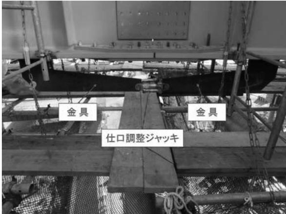
図-8 継手ギャップ調整装置
