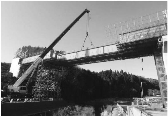
図-10 落とし込み架設状況
