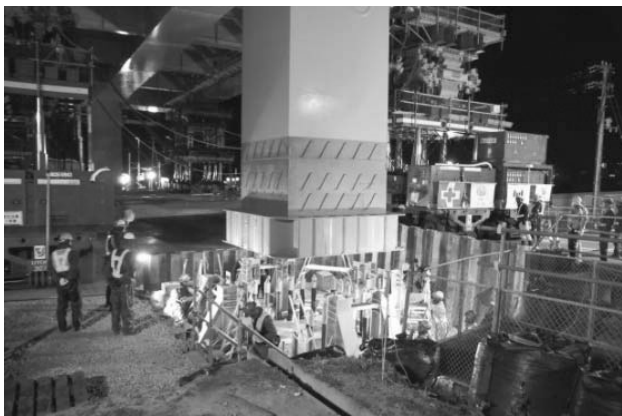
図-9 アンカーボルト挿入状況
