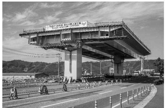
図-11 一括架設完了
