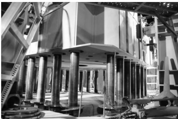
図-10 アンカーボルト挿入状況 (詳細)
