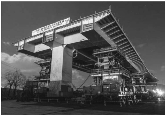
図-1 多軸式特殊台車一括架設状況
