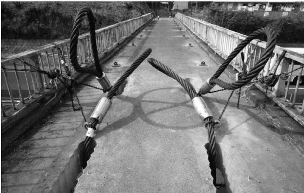
図-4 吊孔削孔とワイヤリング
