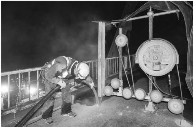
図-8 乾式ワイヤーソー切断状況
