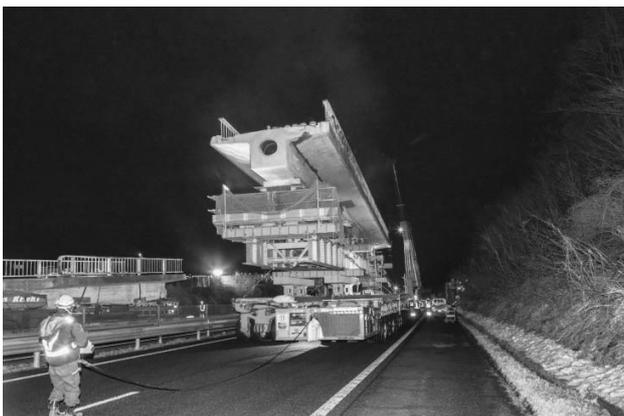
図-9 中央径間運搬状況写真
