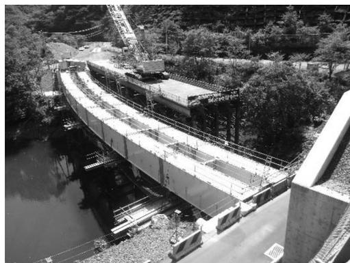
図-15 桁架設完了
