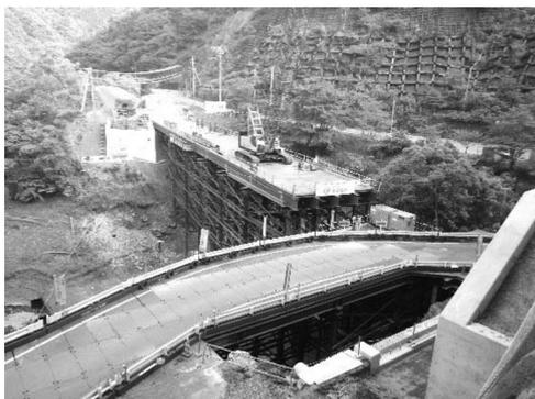
図-11 架設用仮橋完成
