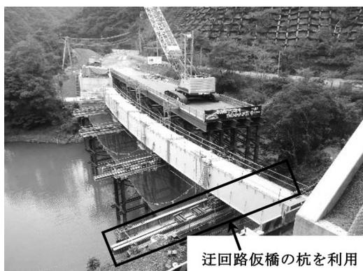
図-12 桁横取り作業前
