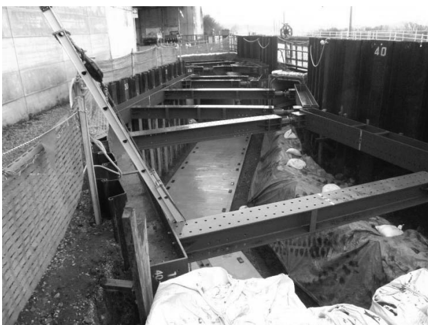
図-7 鋼矢板・山留材状況 右側鋼矢板=高止まり施工(転落災害防止対策)
