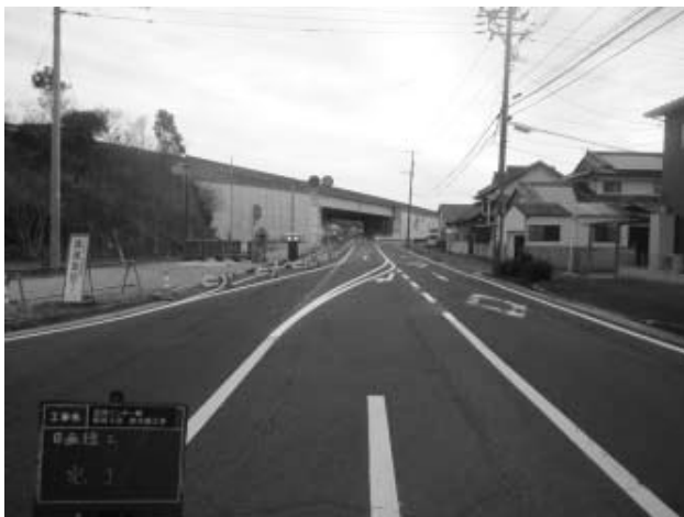
図-4 車線変更完了
