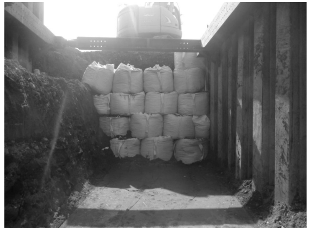
図-10 掘削完了カ所の大型土嚢
