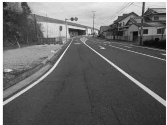
図-2 着手前現況
