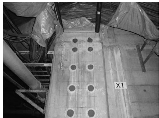
図-5 あと施工せん断補強鉄筋完了
