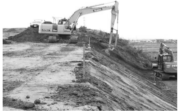
図-4 ポイント杭設置状況
