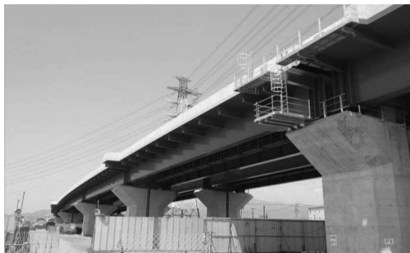
図-1 厚木第一高架橋
