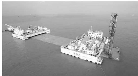
図-5 沈埋函沈設状況
