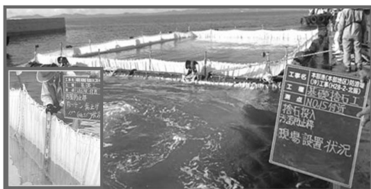
図-4 汚濁防止枠嵩上
