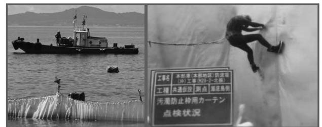
図-7 濁水監視・汚濁防止膜補修
