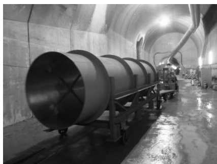
図-6 電動運搬車による牽引
