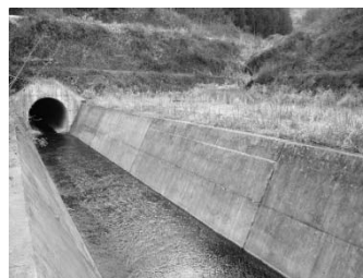
図-2 トンネル入口
