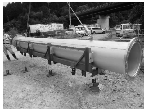
図-7 据付架台と放流管を一体化
