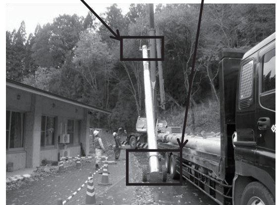
図-4 崩壊土砂防止柵支柱建込み状況
