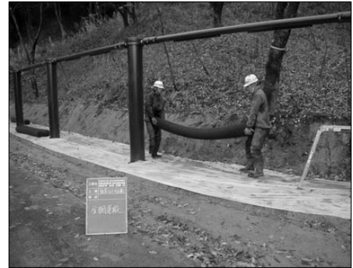
図-3 防護柵設置作業時のシート養生状況
