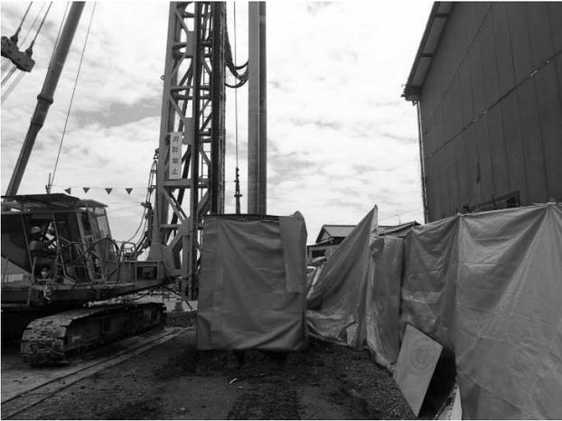
図-1 住宅最近接地盤改良施工
