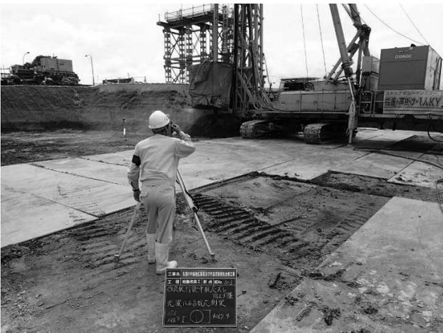
図-2 改良杭施工中の杭位置計測状況
