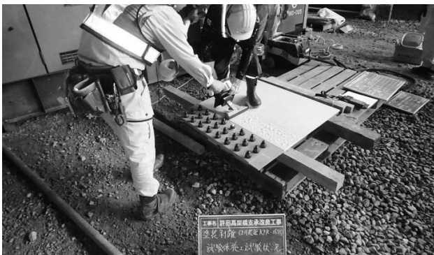
図-3 試験体による施工試験状況
