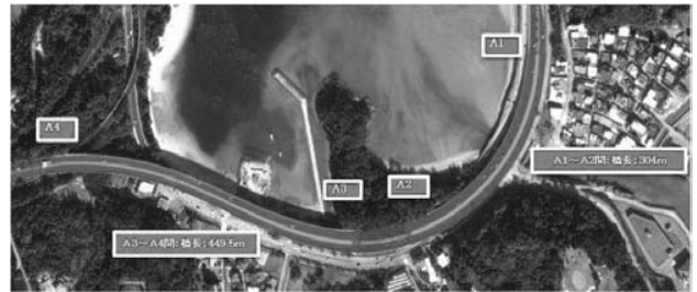
図-1 許田高架橋
