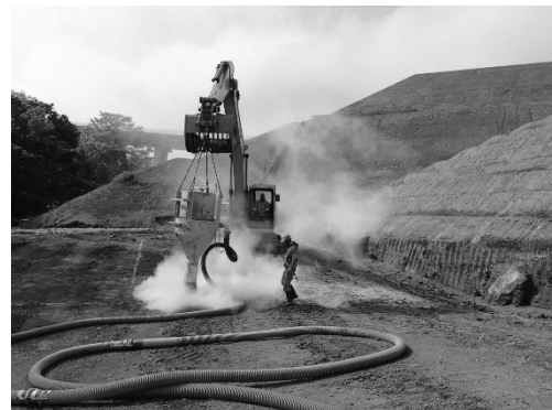
図-3 セメント散布状況
