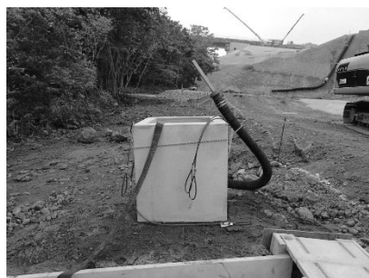
図-4 集水桝とホース接続
