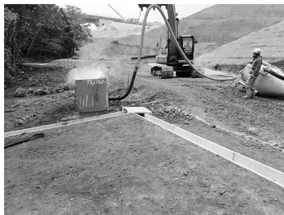
図-8 バラセメント車からの最終圧送
