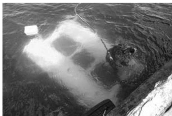
図-4 補強部材曳航状況
